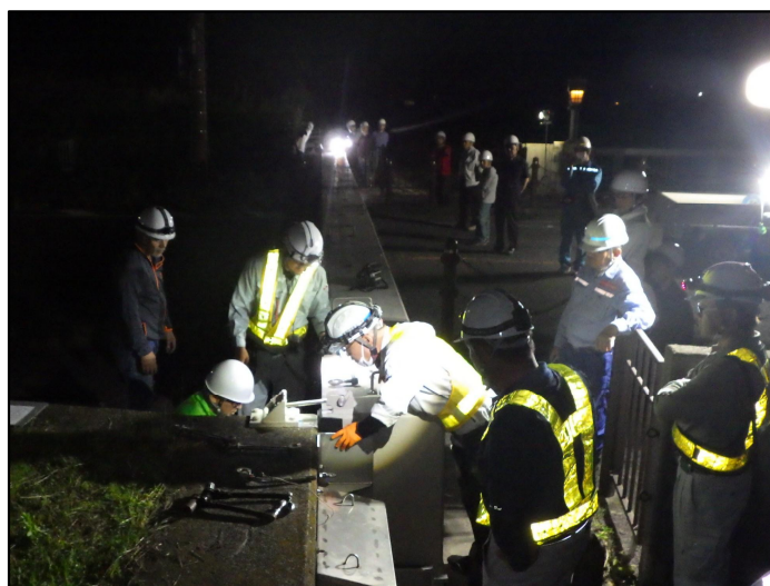
陸閘の施設点検
