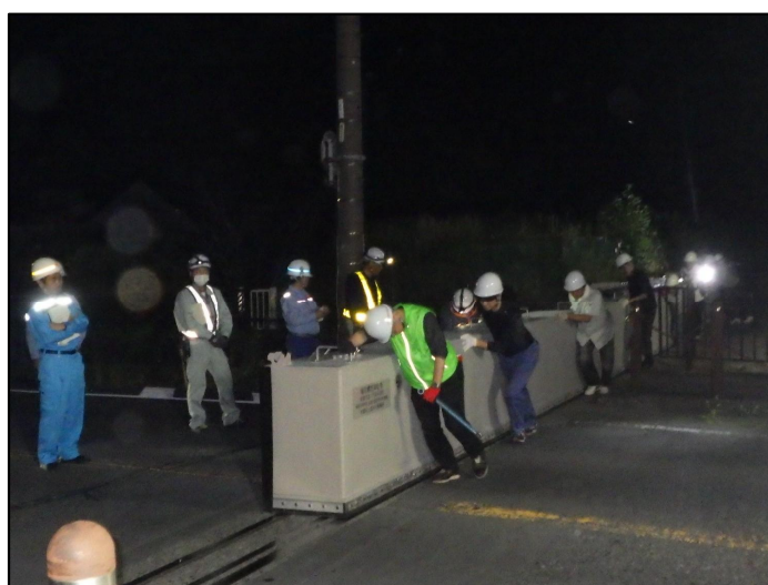
陸閘の閉鎖状況
